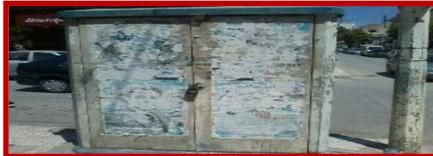
الصورة رقم (39) توصيل الحي بشبكة الهاتف .
