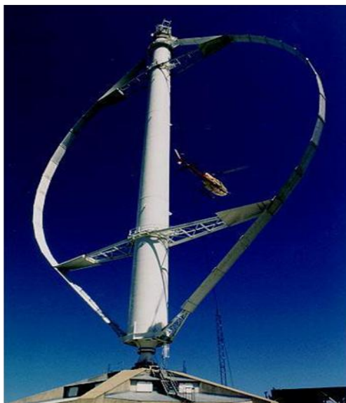
Fig. III.3.a : Éolienne à axe verticale type Darrieus Fig. III.3.b : éolienne à axe verticale type Savonius
