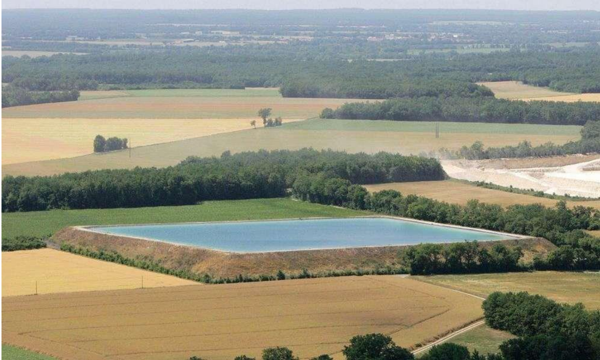
Figure n°4 : L'irrigation par bassin (Image Google).
