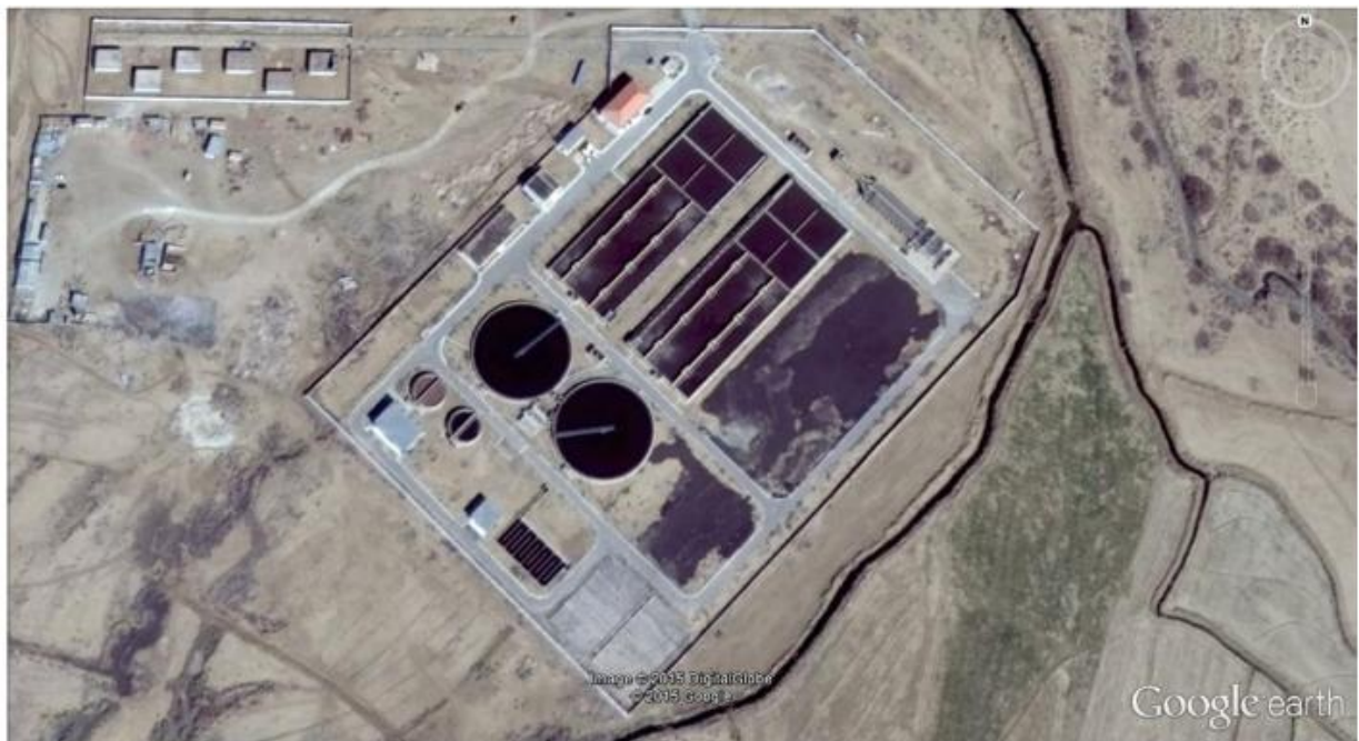
Figure II.1: Vue générale de la STEP de M'sila (à partir de Google earth 2016).
