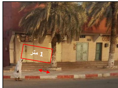
الصورة رقم (24): توضح وجود المسافة الخالية
