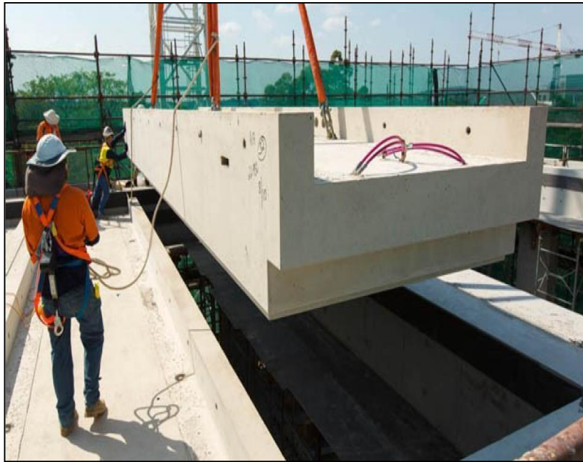
Figure I.3. Poutre préfabriquée à base de géopolymère [RIF 20].
