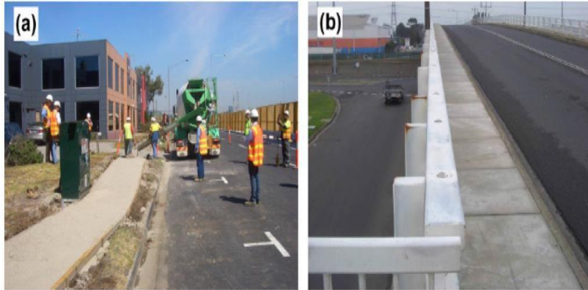
Figure I.10. Utilisation de géopolymère dans des travaux dans un port en Australie [PAS 14]
