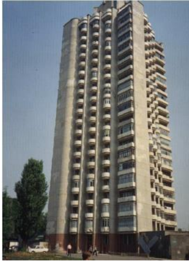
Figure I.8. Premier immeuble en béton géopolymère à Lipetsk, Russie [FAR 18]
