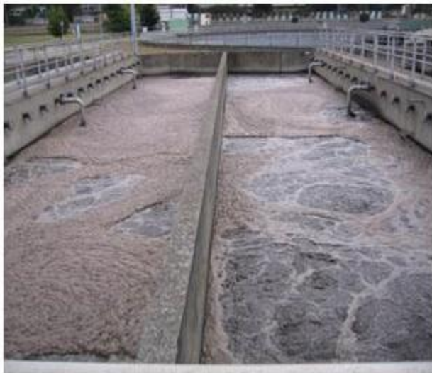
Figure .4. Bassin d'aération (à gauche) et les décanteurs secondaires (à droite) [63].
