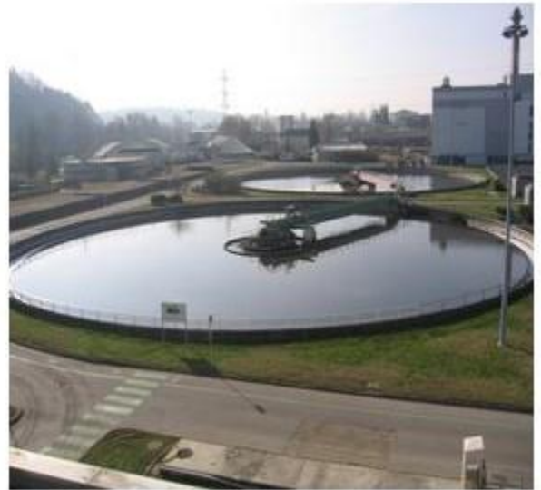
Figure .4. Bassin d'aération (à gauche) et les décanteurs secondaires (à droite) [63].
