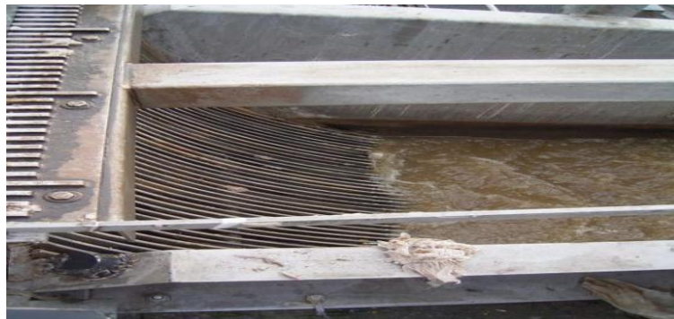
Figure.1 : Lamelles de dégrillage [52].
