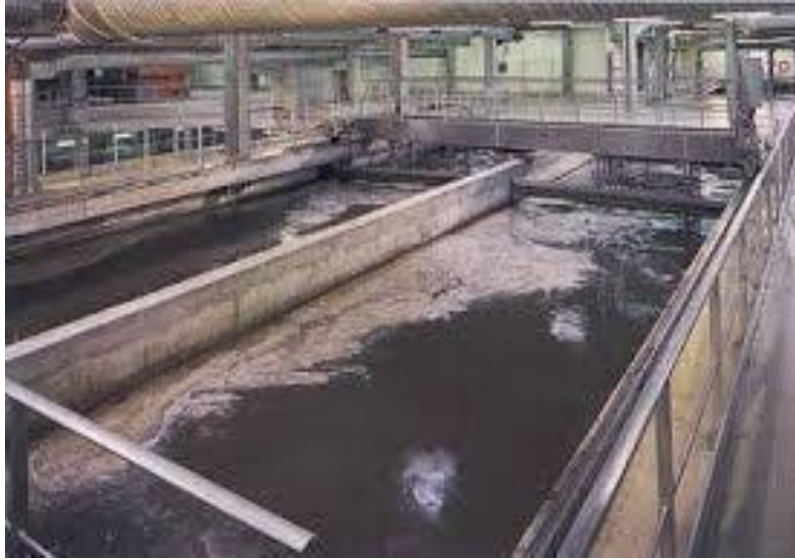
Figure.2 : Désableur-dégraisseur rectangulaire [55].
