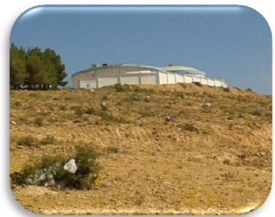
صورة 05 : منحدرات تحتوي على خزاني مياه المصدر: من إعداد الطلبة/2014/06/03.
