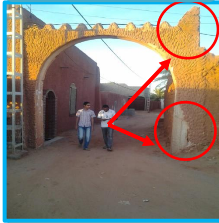
الصورة(43):سور مبني بالمواد القديمة متدهور فيزيائيا
