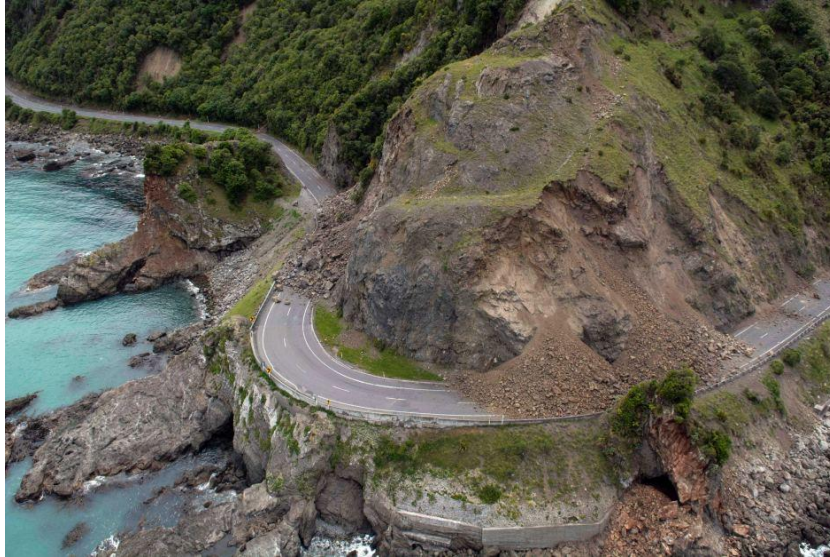
Figure 1.24 – Glissement de terrain à Kaikoura en Nouvelle-Zélande
