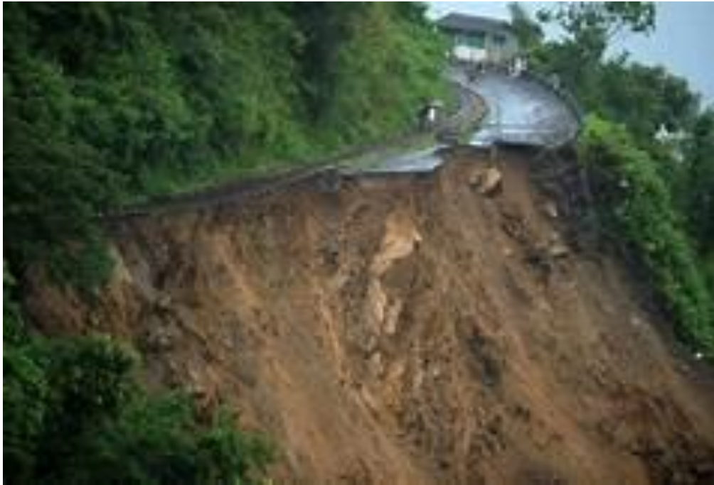
Figure 1.22 - Glissements de terrain dans la région Darjeeling, en Inde (USGS)
