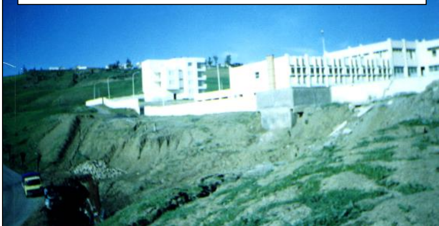
Photo 1 - Vue générale du glissement du terrain au voisinage du Technicum
