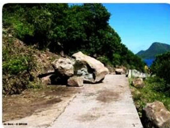
Chutes de bloc sur la route départementale 213 (Terre de Bas)
