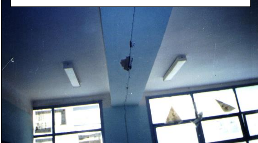
Photo 3 - Vue de l'intérieur du joint de dilatation ouvert
