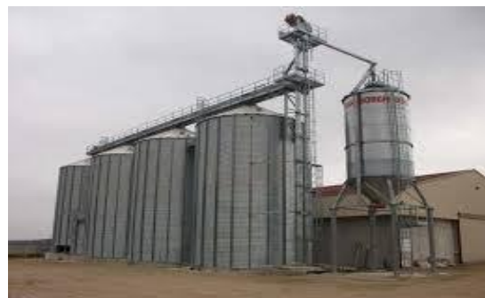
Figure II.9 : Silos pour stockage
