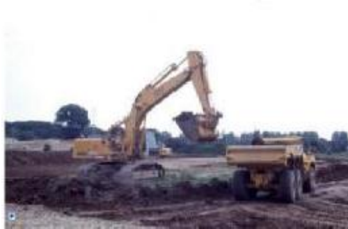
Figure II.2 : Décapage des terres arables en vue du futur réaménagement de la carrière
