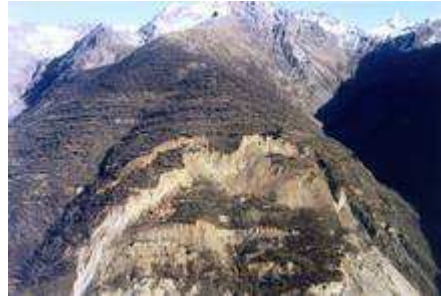
Figure 1.24. Le glissement de La Clapière dans les Alpes-Maritimes en France ( www.savoirs.essonne.fr ).
