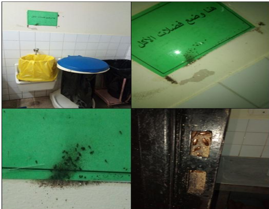
Figure 15. L'hôpital d'Ain elMelh (photo personnel, 2019).
