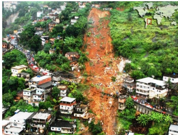
Figure 1.21. : Glissements de terrain Rio de Janeiro au Brésil
