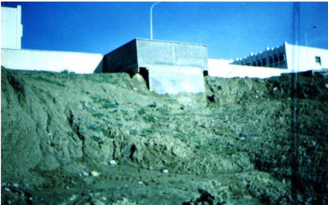
Figure 4.6. : Soute à mazout (ouvrage annexe du technicum)
