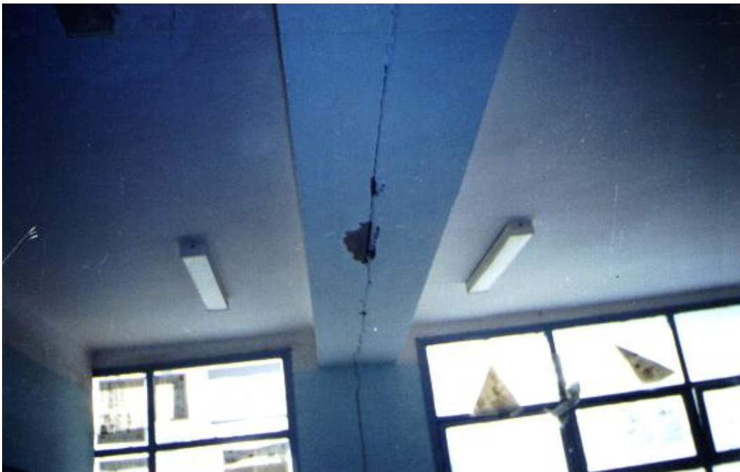
Figure 4.10. : Vue de l'intérieur du joint de dilatation ouvert.
