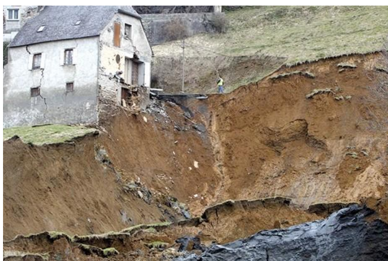
Figure 1.31. : Glissements de terrain de Hammam N'baïls à Guelma
