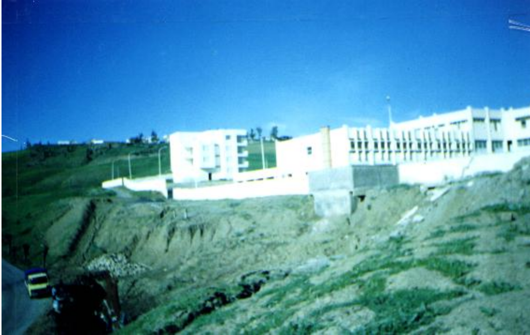
Figure 4.5. : Vue générale du glissement du terrain aux Alentours du technicum
