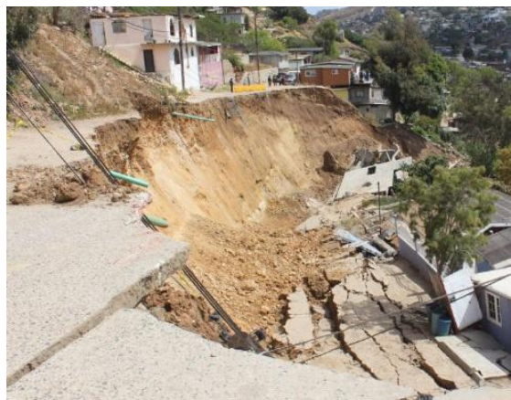
Figure 1.22. : Glissements de terrain dans la colonie Anexa Miramar, Tijuana
