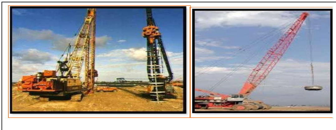
Figure II.2: Compactage par vibro-sonde.
