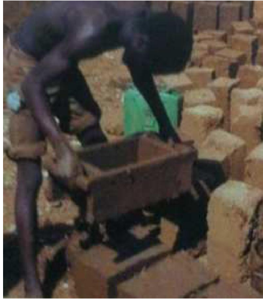
Figure I.12: Le démoulage des briques d'adobe manuel. (lamouri-Hannani, 2014)
