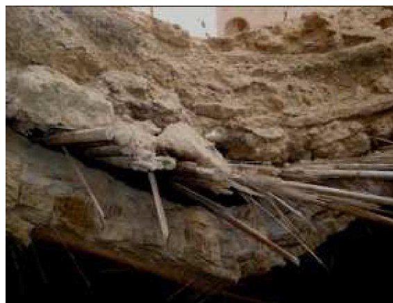
Figure II.3: Fléchissement d'un plancher. (lamouri-Hannani, 2014)
