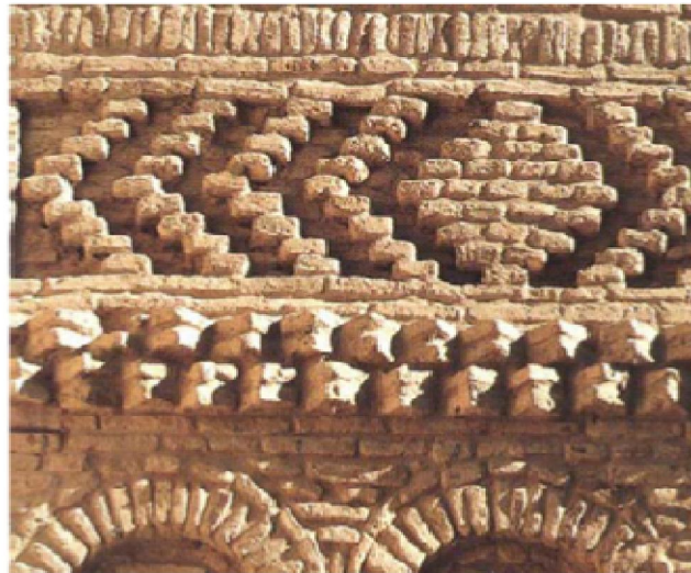
Figure I.11 :Mur extérieur en adobe(terre crue ) (Tahar, 2009)
