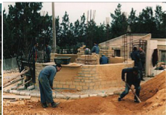
Figure I.8:premières assises du prototype de Souidania 1999 (SAFIA, 2014)
