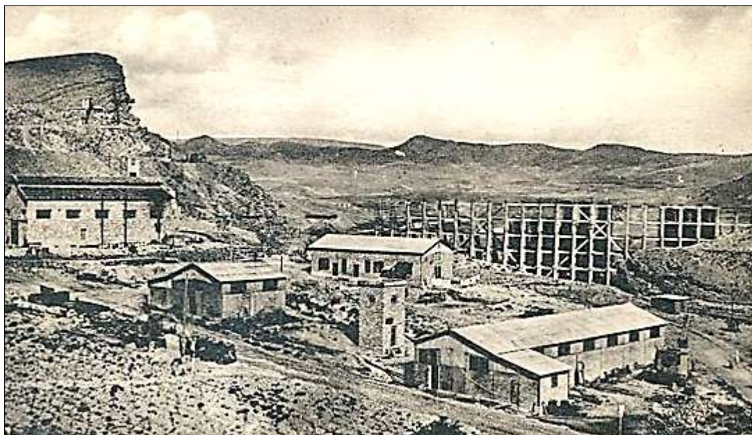
Figure IV.30 : Vue sur le barrage K'sob lors de sa construction.
