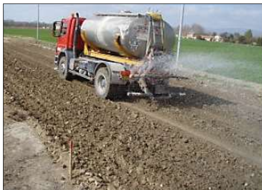
Figure V.37 : Traitement à la chaux (source CETE).
