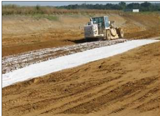
Figure V.38. Traitement à la chaux (source CETE).
