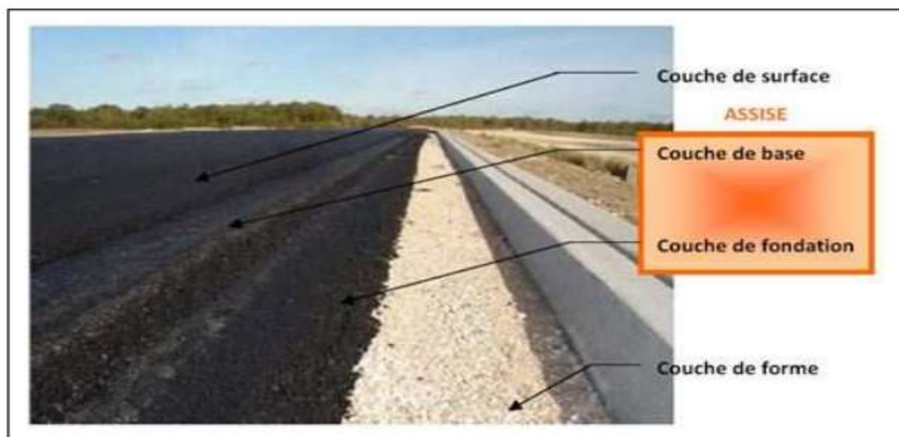
Figure III19: Photo d'une coupe-type de chaussée.
