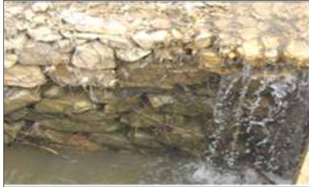
Figure II.9:Seuil de sédimentation en gabions et en pierres sèches.
