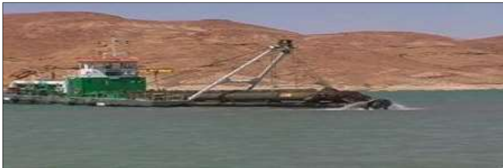
Figure II.15 : Dragage activant dans la retenue du barrage Foug-El-Gherza (Biskra).
