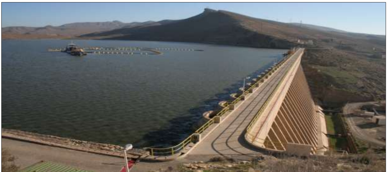
Figure I.1 : Barrage K'sob (d'après : www.soudoud-dzair.com ).
