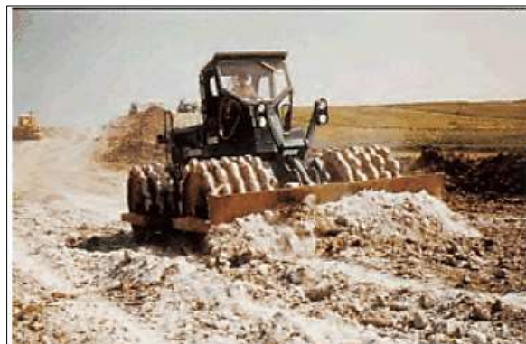
Figure V.39. Traitement réactifs (source SETRA).
