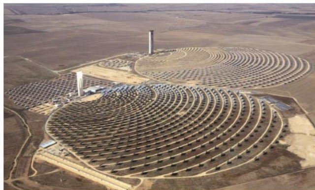
Figure I.4 : Centrale solaire thermique PS20 (20 MW) (Espagne) [2].
