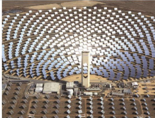
Figure I.3 : Centrale solaire thermique pour production d'électricité (150 MW) (Boutarfa, Algérie) [2].
