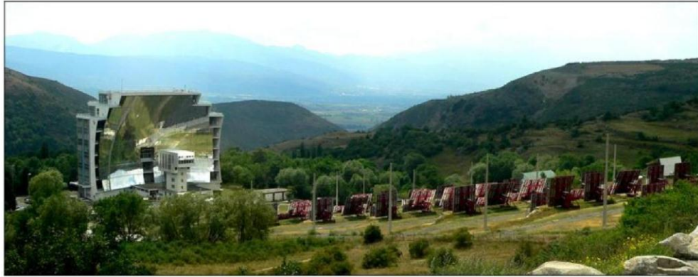
Figure II.1 : Le four solaire d'Odeillo. A gauche, le miroir parabolique qui concentre les rayons du soleil. A droite, les 63 héliostats qui réfléchissent les rayons vers le miroir parabolique [5].
