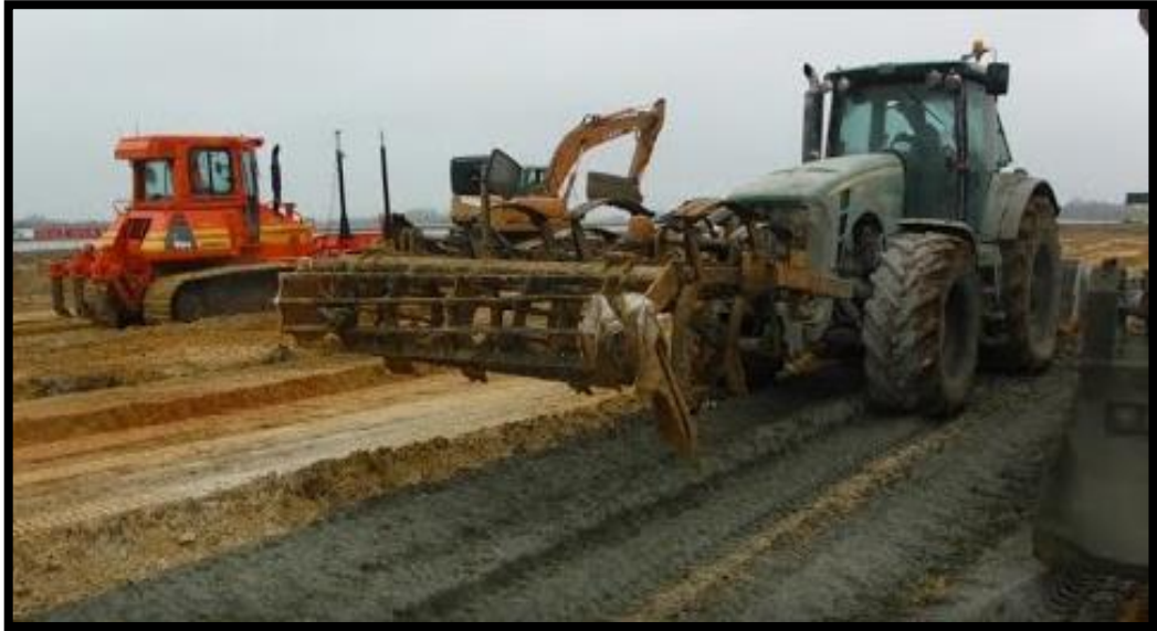
Figure I.22 : Traitement des sols au Ciment.
