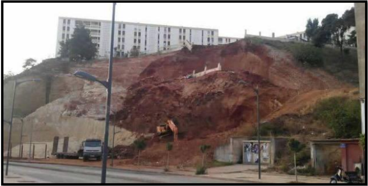
Figure I.12 : Glissement de terrain sur la route menant d'El-Mouradia vers Bir Mourad Raïs (Alger) 01/2019
