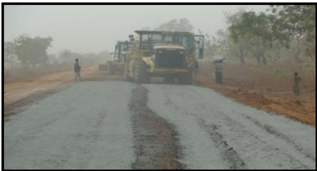
Figure II.4 : Malaxage du ciment sur chantier.
