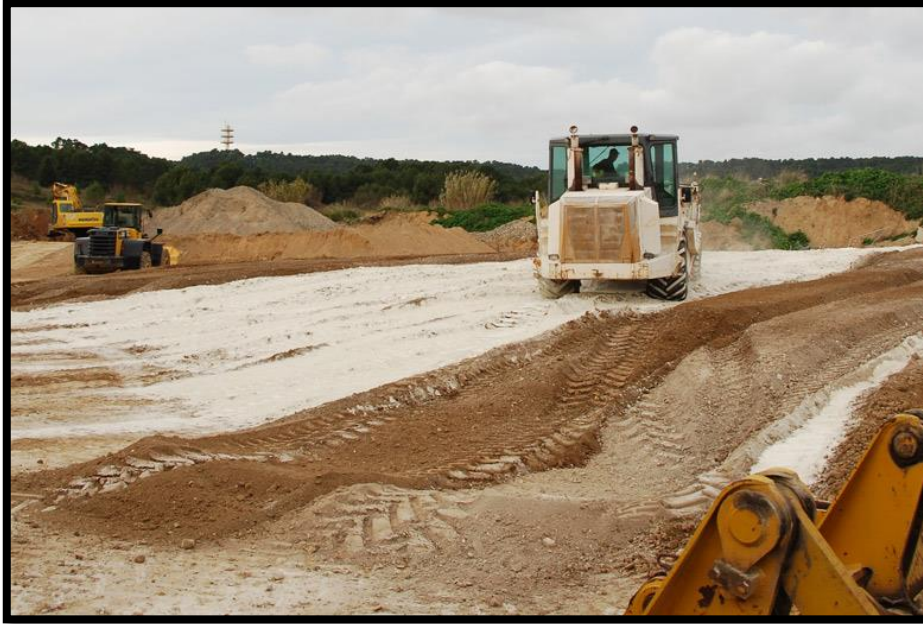
Figure I.21 : Traitement des sols à la chaux.
