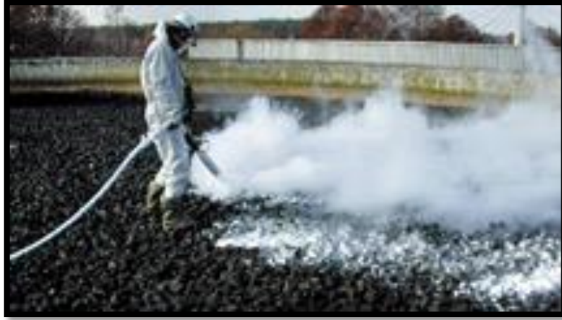
Figure I.19 : La congélation du sol sur chantier.
