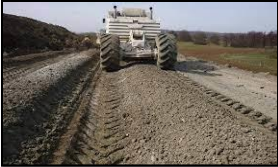
Figure II.3 : Préparation de la couche de forme.
