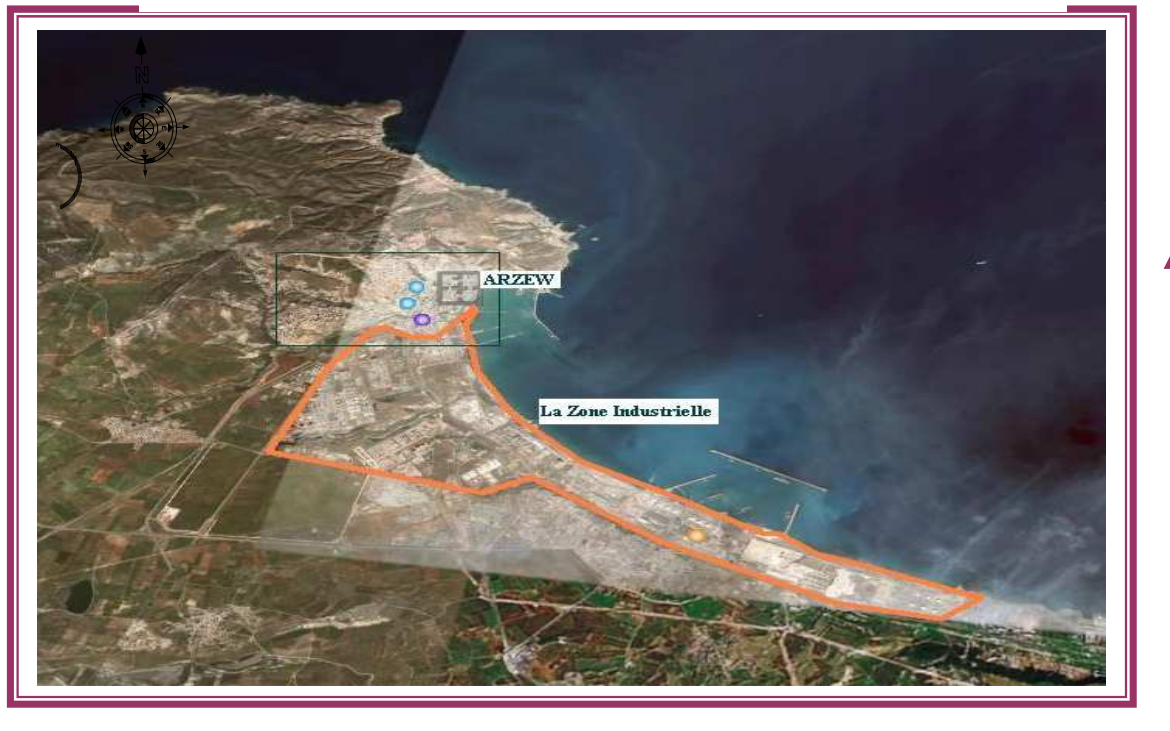
Fig N° 04 : La situation de la zone industrielle d'Arzew
