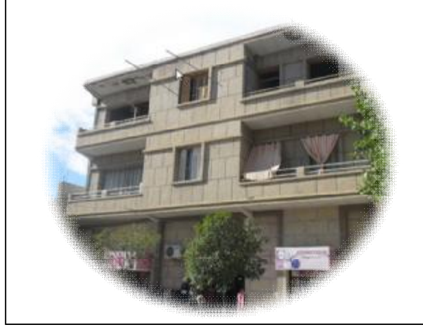
الصورة رقم (01) : سكن تم تجديده
