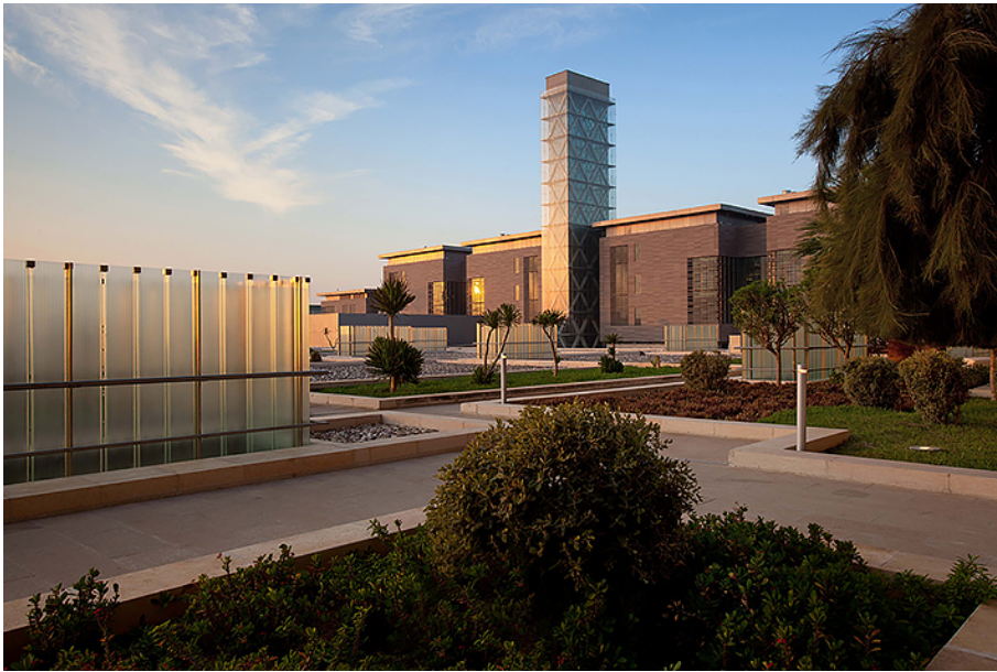
الشكل (1.16): مدخنة شمسية عمودية بجامعة عبد الله للعلوم و التقنية [16]
