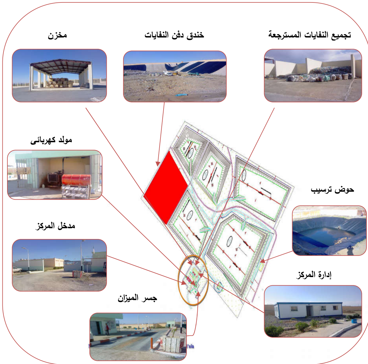
صورة (19): تهيئة مركز الردم التقني لمدينة المسيلة.
