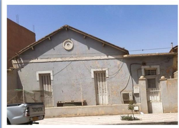
صورة رقم (07): بناء قديم
