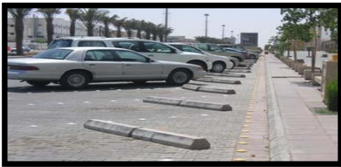
شكل رقم (09) : شكل وابعاد المصدات الحاجزة قرب الارصفة
