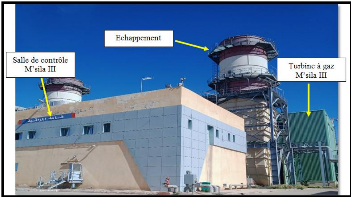
Figure I.4 Groupe de turbines à Gaz V94.3A de (M'sila III)
