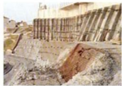
Figure 1.35:Tirant d'encrage.
