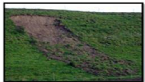
Figure (b) : exemple d'un glissement plan
