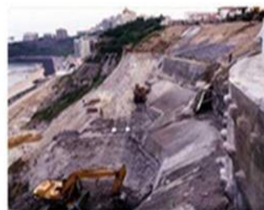
Figure 1.25 : mise en œuvre de terrassements.
