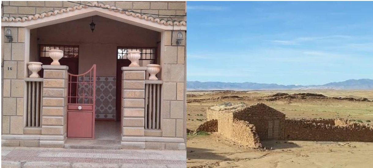
Figure 67 : Applications actuelles et historiques du calcaire dans le secteur de la construction.
