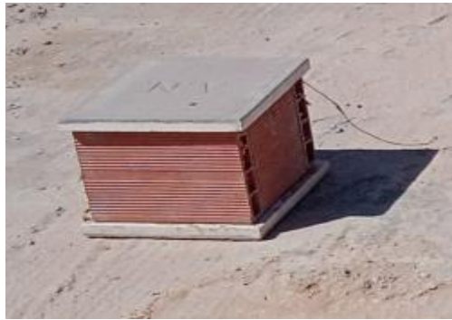
Figure 10 : Chambre creuse en brique rouge .
