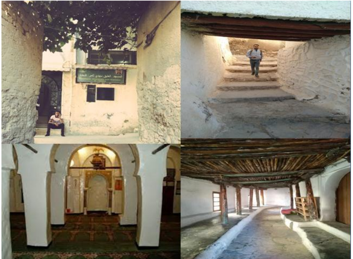
Figure I.19 Djamaa-en-nekla (Exemple de l'architecture islamique). (Photo : SAADAoui Benaceur OUAHAB Yamina)
