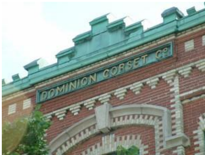
Figure I.2 Détails architecturaux en brique de l'édifice La Fabrique, Québec. Photo Martin Dubois.
