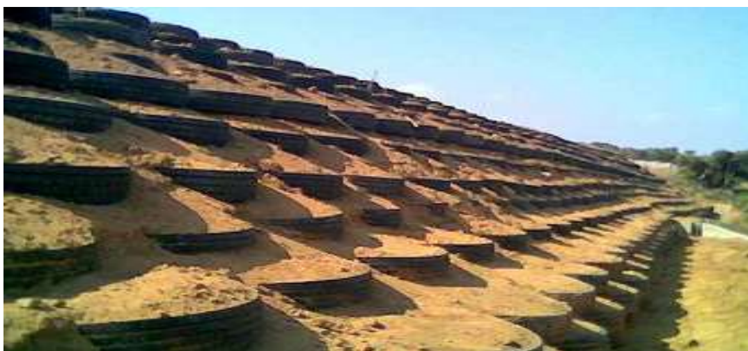
Figure III.4. Chantier expérimental Pneusol à Bou-SmaiL [34]
