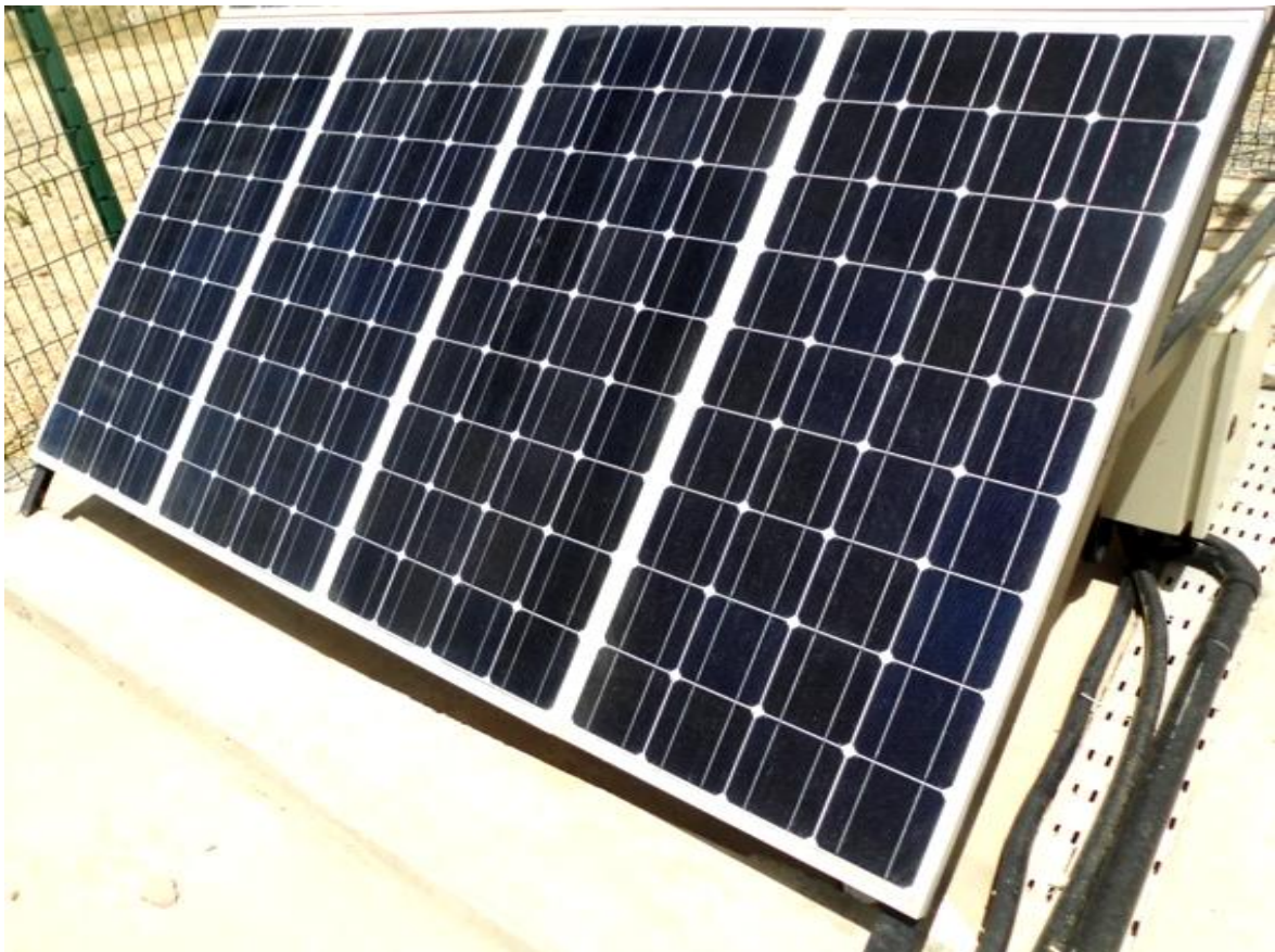
Figure 4.12. Photographie des panneaux PV de type STP085S-12Bb.
