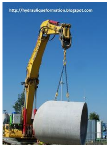
Figure VI.3: pose de la canalisation.
