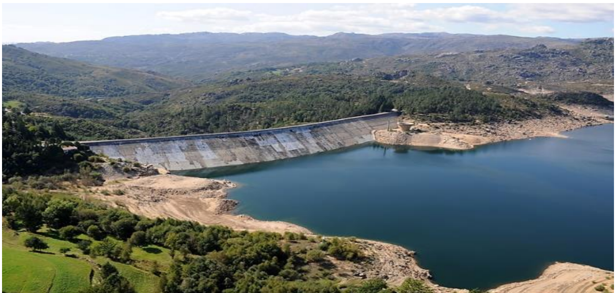
Figure I-4 : Barrages en enrochement (Barrage Paradela)
