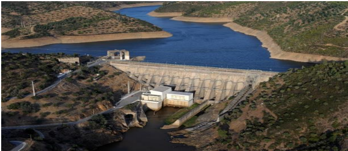
Figure I-8: Barrage à counterforts Barrage de Pracana
