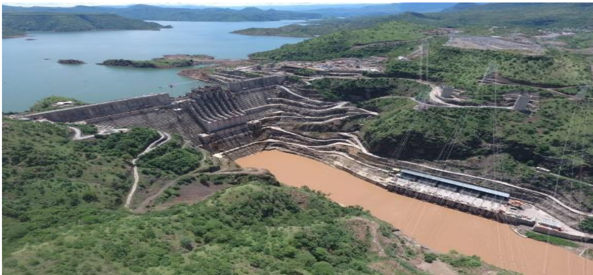
Figure I-9 : barrage (BCR)de Gibe III, en Ethiopie.
