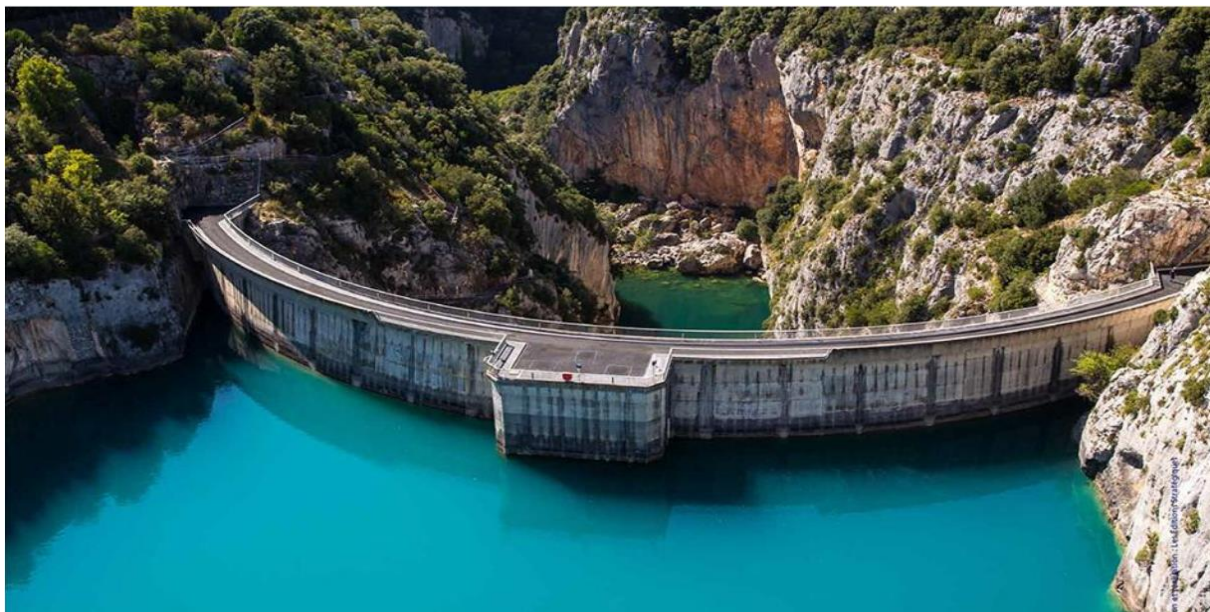
Figure I-7 : barrages voûtes
