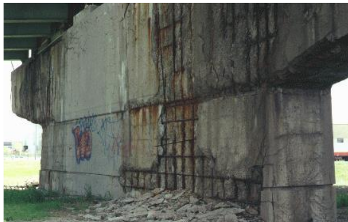
Figure 1.8 : Agression du béton par activité des chlorures. [26]
