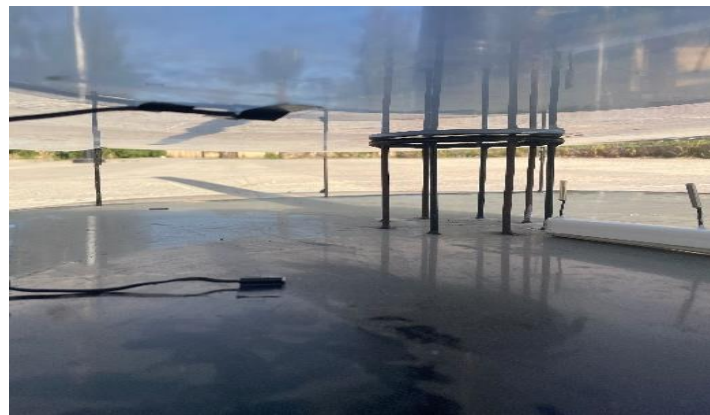
Figure (II.5.b) : Le capteur de température en bas sur l'absorbeur.
