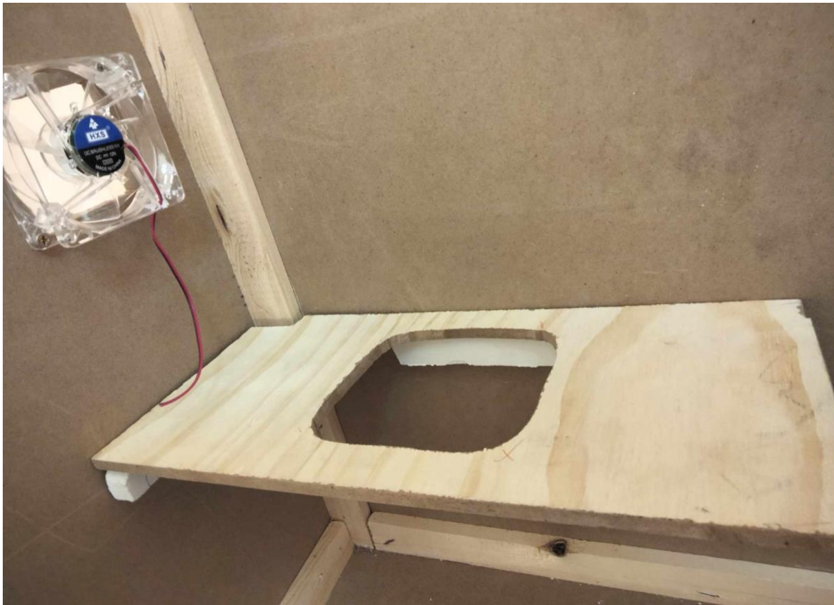
Figure n°24: Installation du premier ventilateur PC responsable de l'introduction des gaz dans la chambre de filtration
