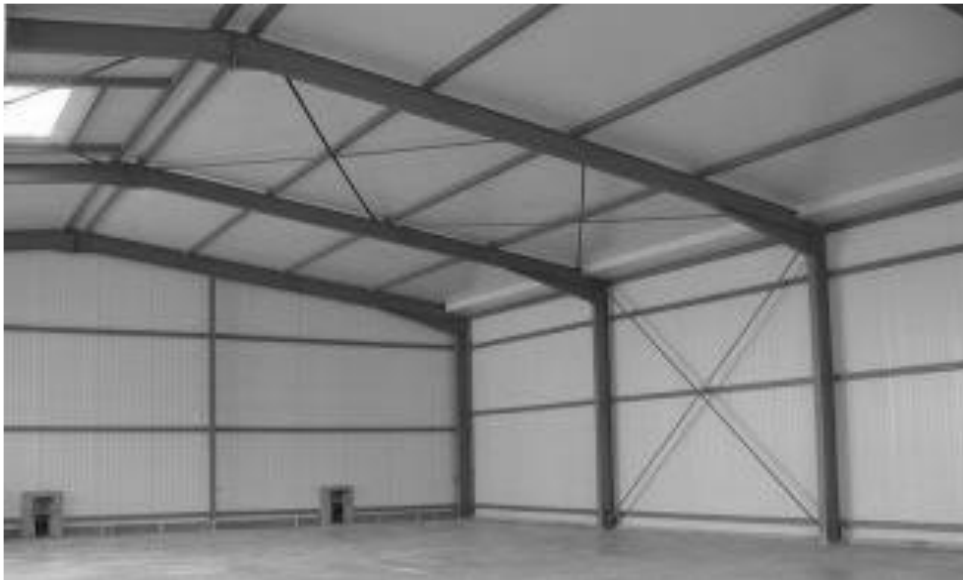
Figure1. 9 : Détails du contreventement
