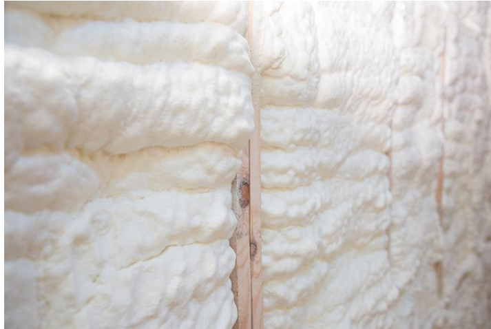
Figure 27: isolation par mousse polyuréthane projetée
